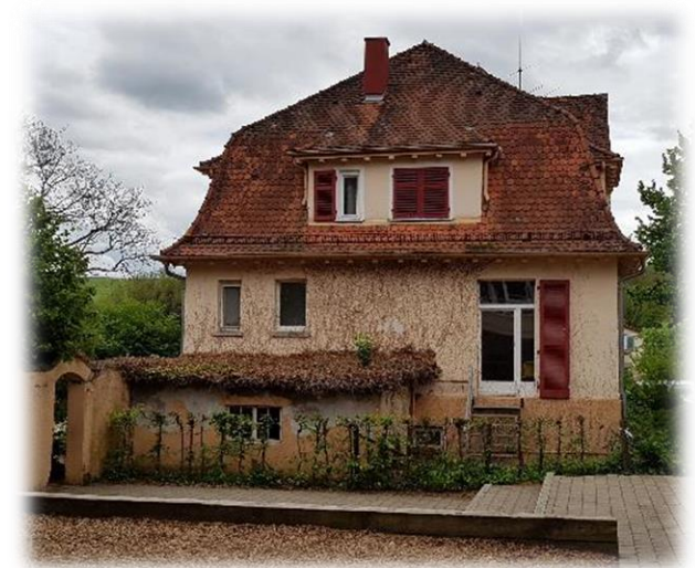
Das renovierungsbedürftige Gebäude in der Schulstr. 21
